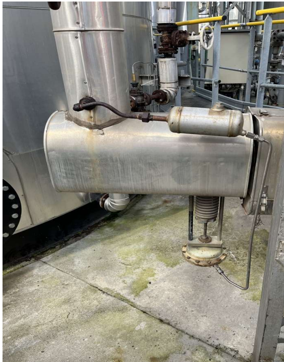
Figure 1: Détendeur situé dans le parc V7
