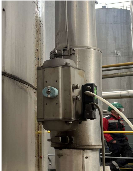
Figure 3: Vanne automatique d'approvisionnement en vapeur du bac T2615 en position ouverte
